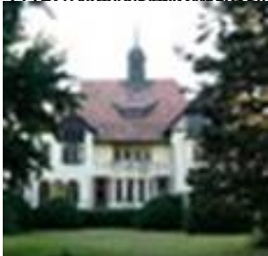
Óklatás kastély (Kecskeméti Nemessömlyén), szecessziós, 1905. Tervezte Moravetz Zsigmond.
